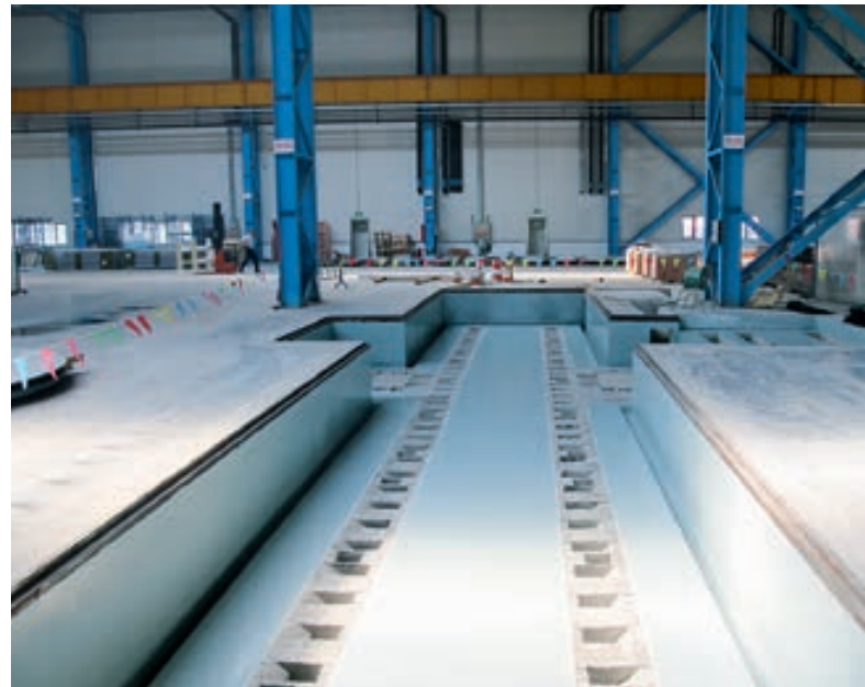
Fundamentarbeiten in Qingdao
