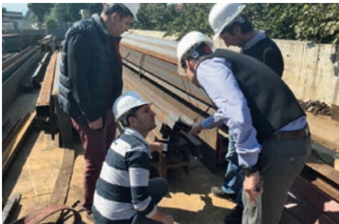
Oben: Bauteilmarkierung mittels Hartstempelung Mitte: Glätten der Schweißnähte (grinding process) Unten: Expeditoren der SPG im Einsatz
