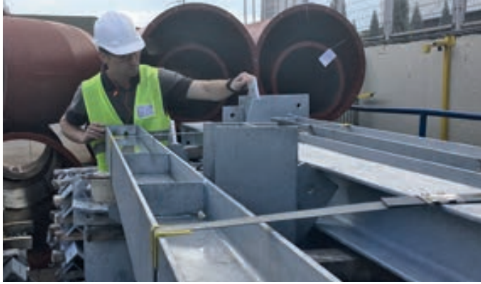
Sichtkontrolle der verzinkten Stahlbauteile vor dem Verladen
