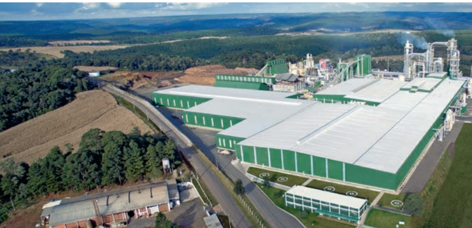
Betriebsgelände in Caçador
