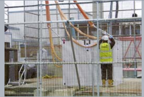
Anbringen der Anschlagmittel zum Transport in 5,20 m Höhe
