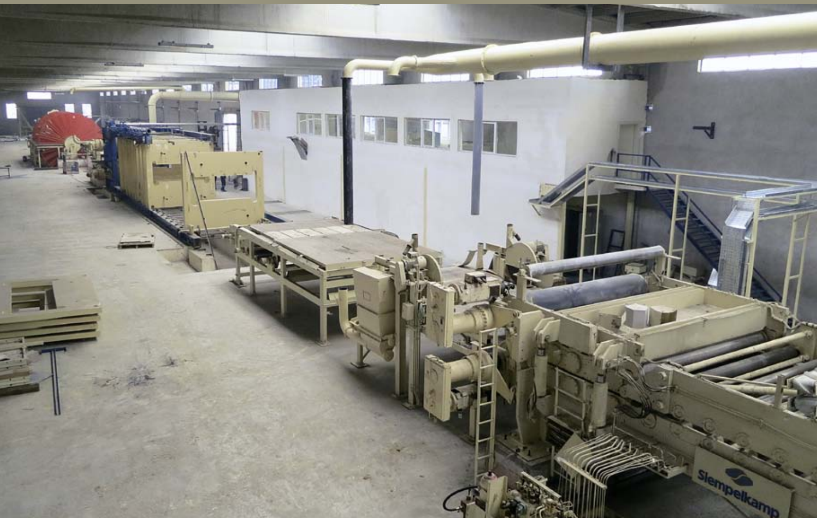
Form- und Pressenstraße während der Montage
