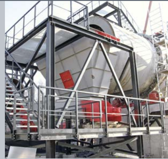
Montage in Gulbene: Ausfallseite des Trommel-trockners, im Hintergrund der Ventilator
