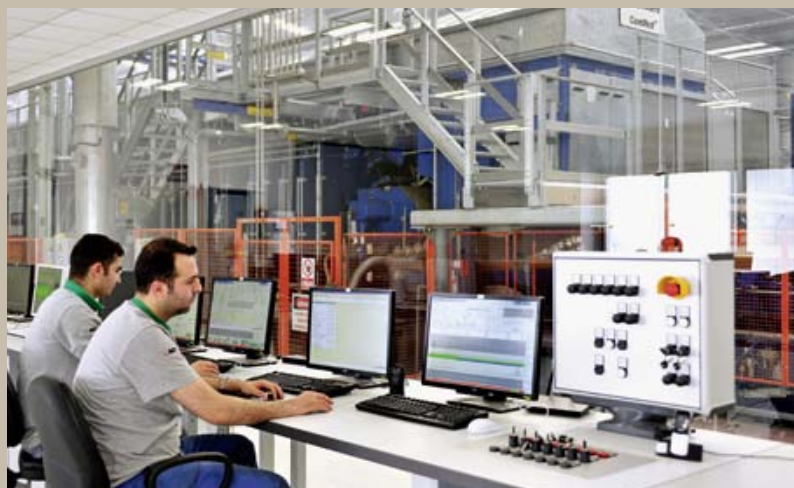
Leitstand zur Anlagensteuerung
