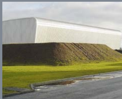
Magnox Zwischenlager in Berkeley mit einer Lagerkapazität von bis zu 1.004 Behältern
