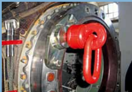
Vordere Deckenaufhängung am Einstiegsflansch
