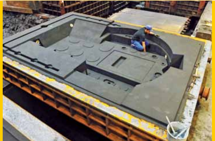
Formarbeiten für die Prototypen
