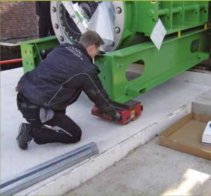
Generator beim Einbau in das Gebäude
