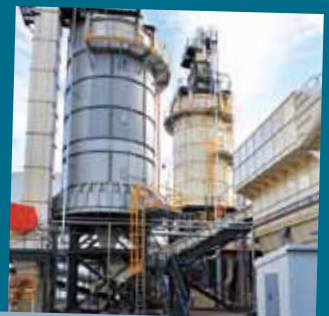
Deck- und Mittelschicht-Silo
