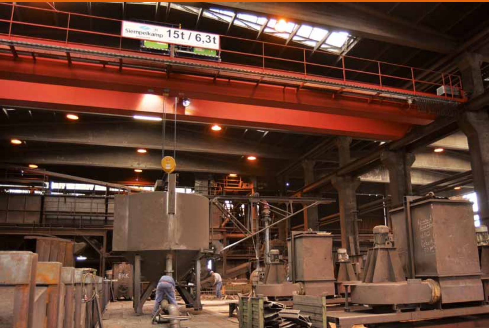
Transport einer Absaugvorrichtung mit der Siempelkamp-Krananlage
