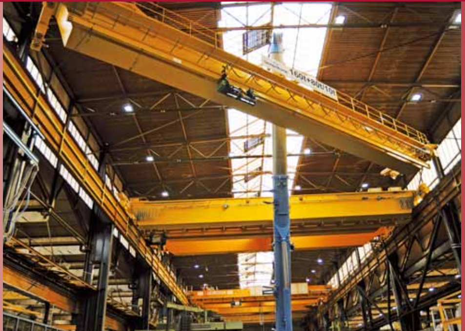
Der Kran nimmt seine Position ein
